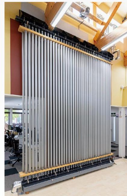
工場壁面に設置された水冷システム。約95%の省エネ効果を実現した。
