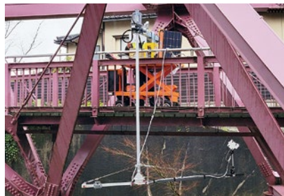
橋梁の状態はカメラで確認し、作業員は安全な橋の上で作業
