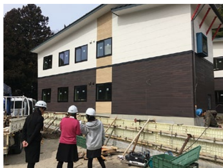
各工事現場を環境パトロールの様子。
