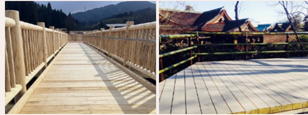
施工例「ふくい健康の森の木橋」(左)「京都北野天満宮デッキ」(右)
