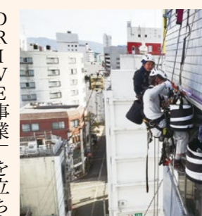
一見不可能に見える高所の調査・工事をロープアクセス工法で解決。
