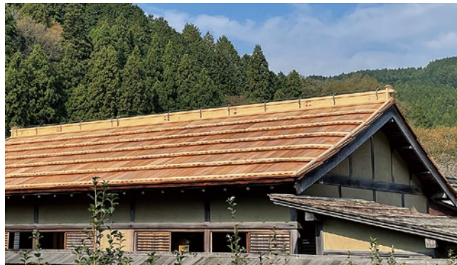
施工事例。一乗谷朝倉氏遺跡武家屋敷屋根の改修工事や京都の北野天満宮デッキをはじめ、全国各地で広く用いられています。
