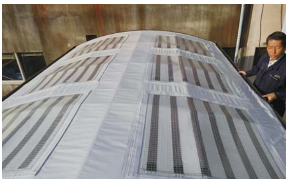
カーポートの天井構材として利用された例。黒いラインに見える部分が発電体になっています。
