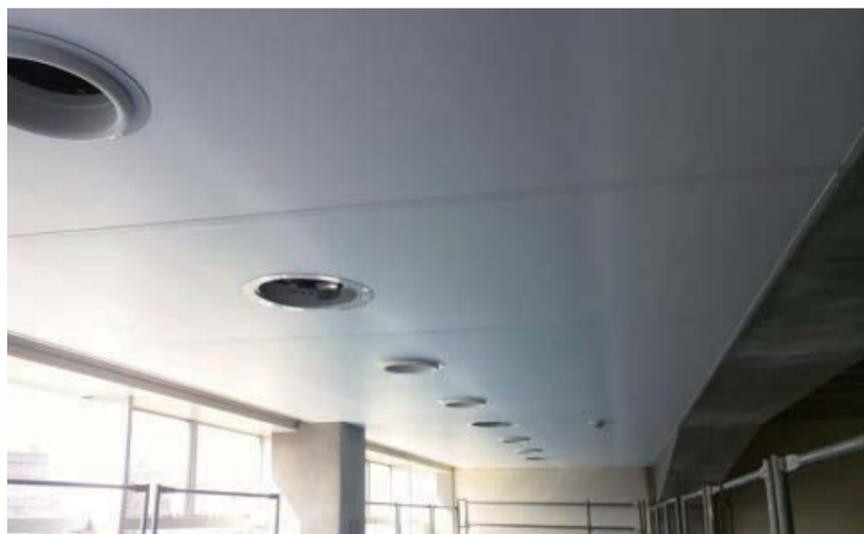
天井材は人々の頭上に重力に逆らって設置されるものであり、万が一の落下時を考えると安全性については十分考慮すべき材料にも関わらず、施工性やコスト等安全性以外の要因で材料が選定されてきました。この膜天井（リフォジュール不燃膜天井）は、不燃性でありながら、0.6kg/m<sup>2</sup>（一般的な天井材である石膏ボードと比べて 1/10 以下の重さ）と非常に軽く、万が一落下したとしても素材が柔軟で衝撃が少なく、安全性が高い仕上げ材です。また独自の小型レールで固定することによりフラット性が高く美しい天井面を実現しており、インテリア材料としても違和感なく溶け込みますようになってきました。「布のように軽くて柔らかいシートを美しく」安全性と意匠性が両立されており、これからの天井材のスタンダードになるのではないのでしょうか。
