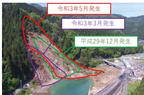
図3 福井市蔵作における大規模崩壊（提供：福井県）
