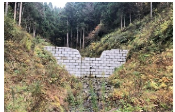
図6 現地調査で確認された治山ダム
